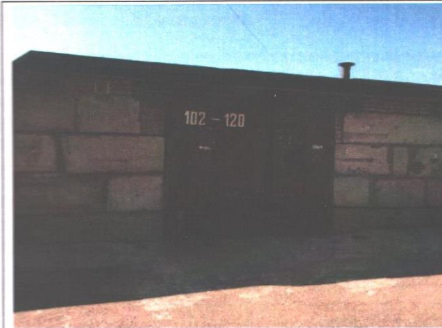
Фотография 3.3. Въезд в блок 4 этажа
