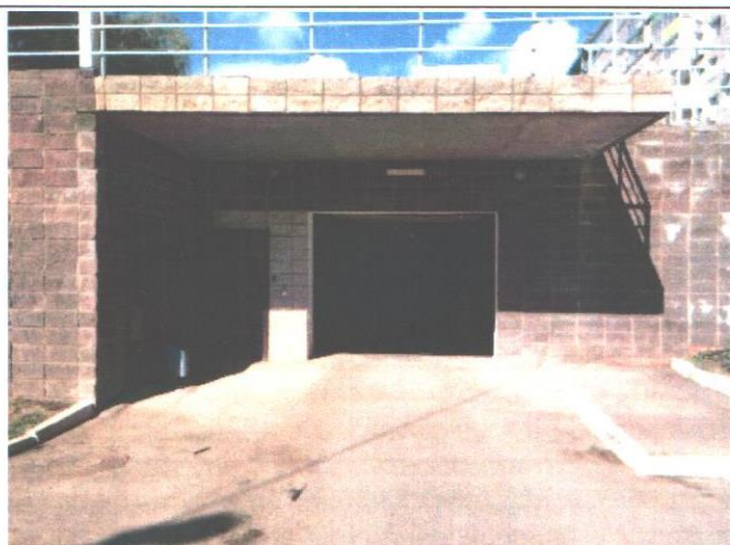
Фотография 3.4. Въезд в здание паркинга
