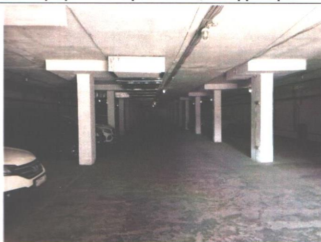
Фотография 3.5. Общий вид помещения здания
