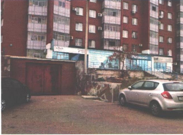
Фотография 3.3. Въезд в здание паркинга
