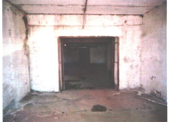
Фотография 3.4. Общий вид помещения здания
