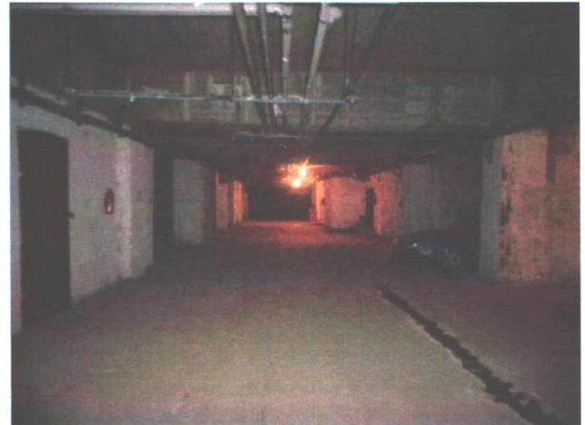
Фотография 3.6. Общий вид помещения здания
