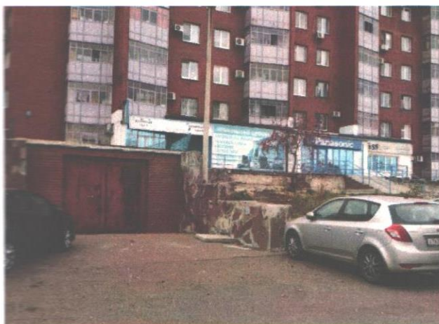
Фотография 3.3. Въезд в здание паркинга
