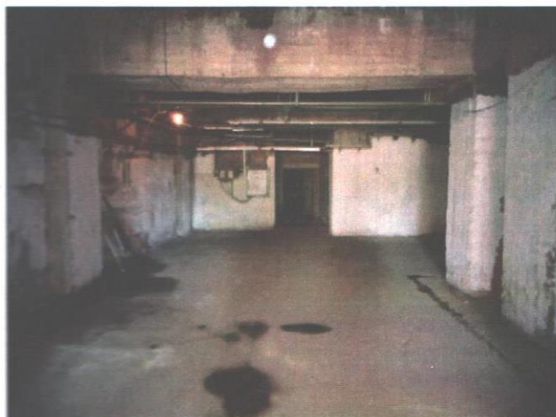
Фотография 3.5. Общий вид помещения здания
