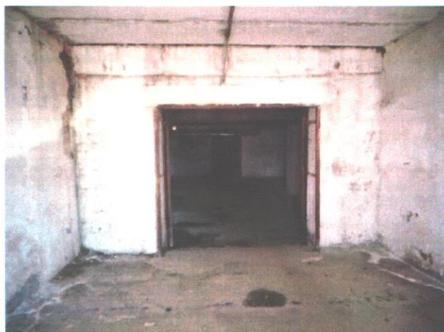
Фотография 3.4. Общий вид помещения здания
