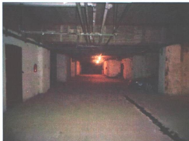
Фотография 3.6. Общий вид помещения здания
