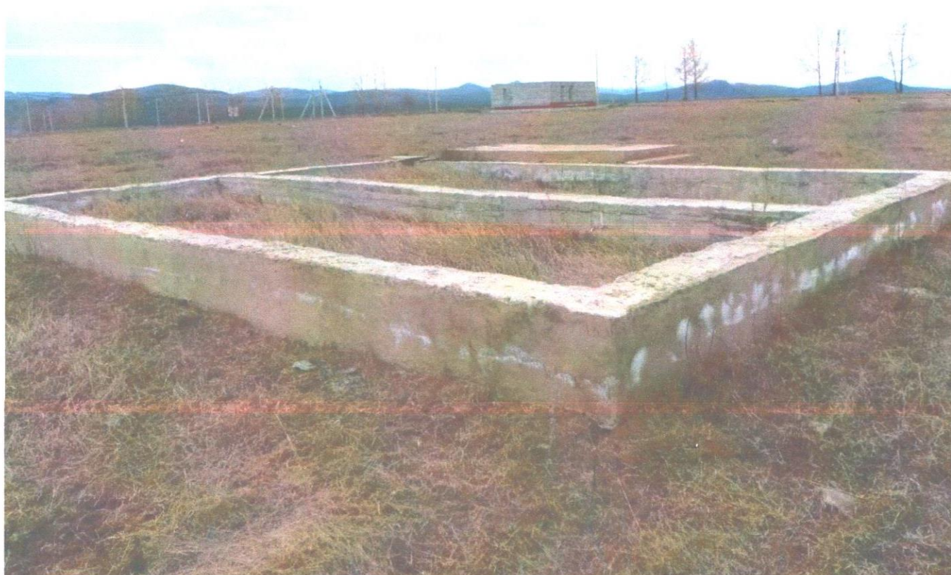
объект с кад.№ 02 11 181301 13 78 (1).JPG
