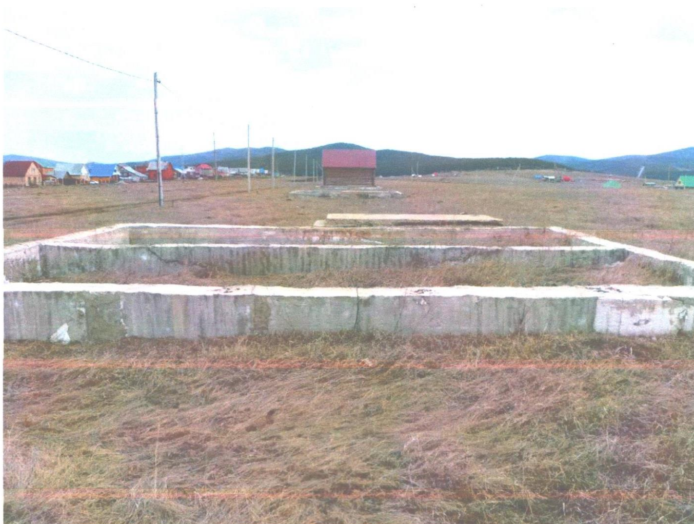
объект с кад.№02 11 181301 13 81 (2).JPG
