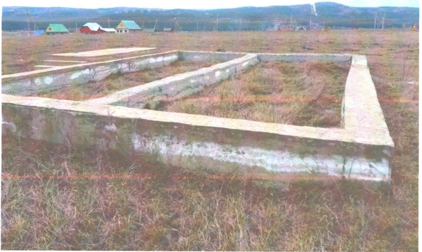
объект с кад.№ 02 11 181301 13 69 (2).JPG
