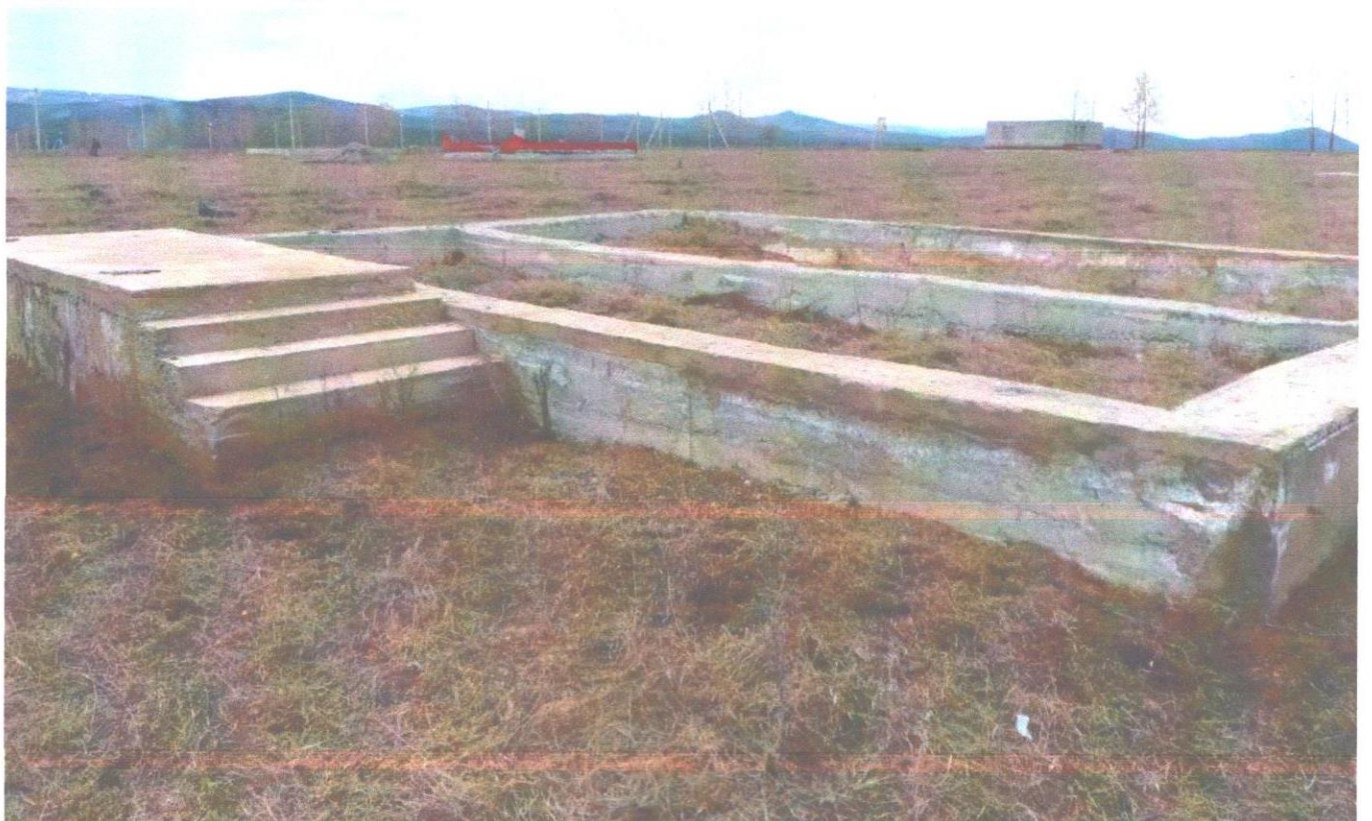
объект с кад.№ 02 11 181301 13 69 (3).JPG
