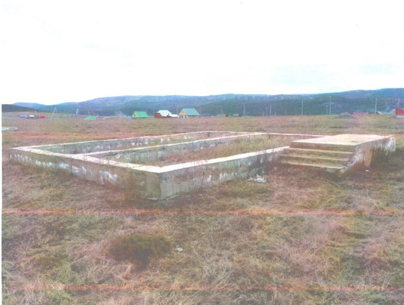
объект с кад.№ 02 11 181301 13 78 (2).JPG
