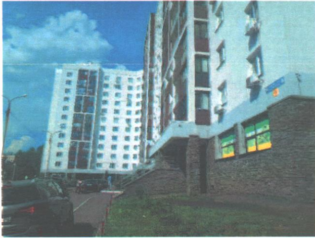
Фотография 3.1. Общий вид здания
