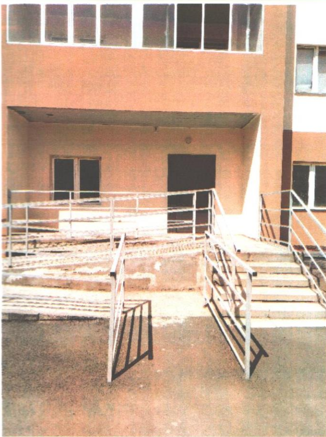
Фотография 3.3. Вход в помещение
