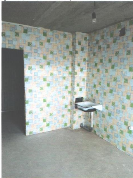
Кухня, 11,0 кв.м. (помещение № 2)
