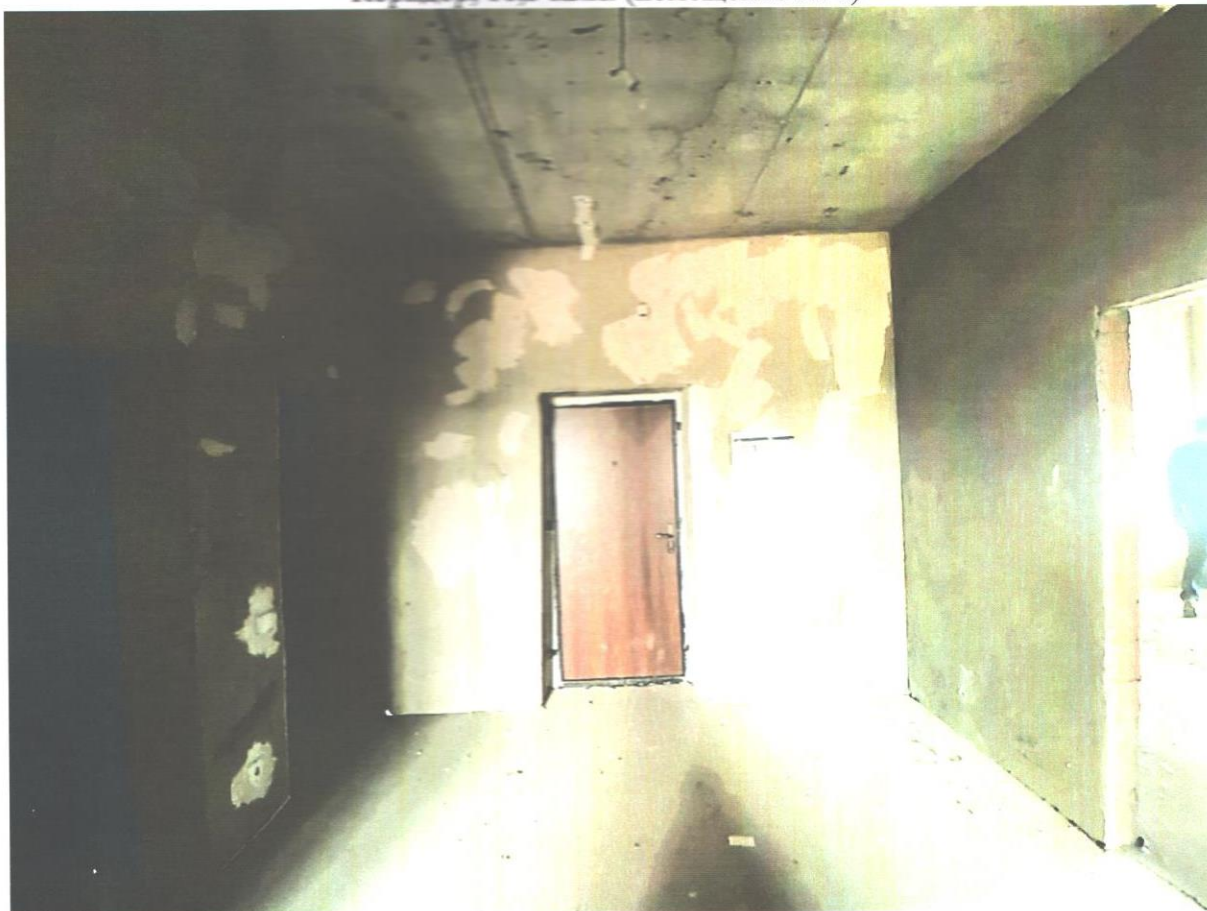
Коридор, 16,3 кв.м. (помещение № 1)
